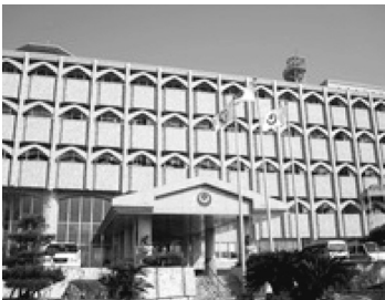
八重山支庁舎
