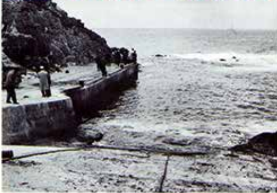
↑ 改修工事が完成した船泊港、長さ20メートルの棧橋と長さ218メートル、幅員5メートルの道路の建設および運搬工事は米国資金160,000ドルで完成した。
