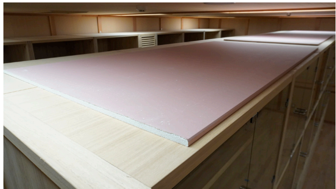
図 10 木製収納棚天板に設置されたホルムアルデヒド吸着石膏ボード
