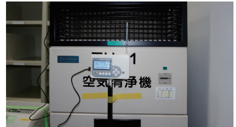
写真4 排気口での測定
