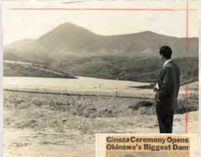
「宜野座ダム竣工」
