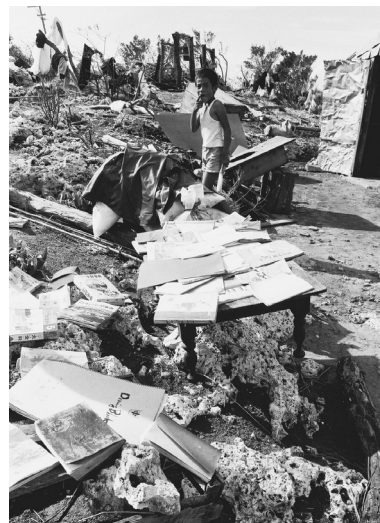
039494 石垣島1971年9月 台風被害視察
