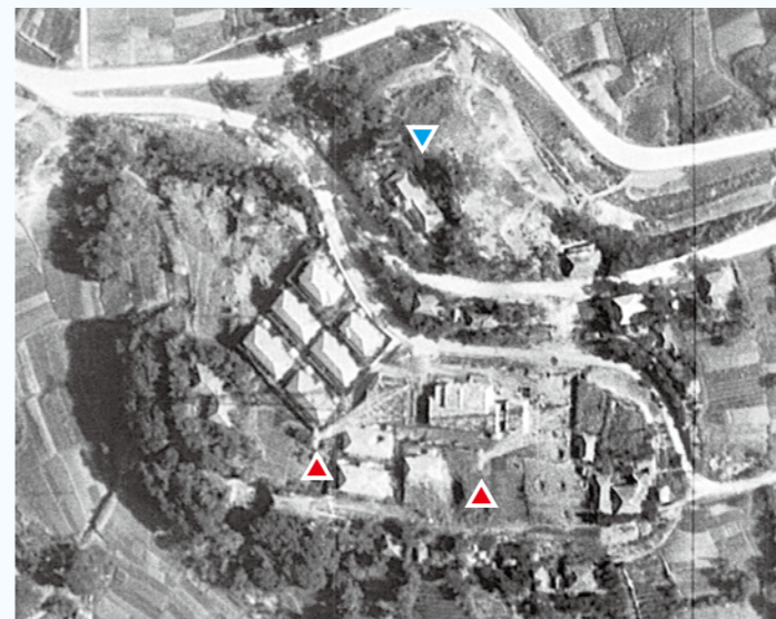
③ 首里観音堂 (▼) 付近にあった鉄塔 (▲) (1945年4月2日) (資料コード:KS00000093 [ON27835 その 061])
