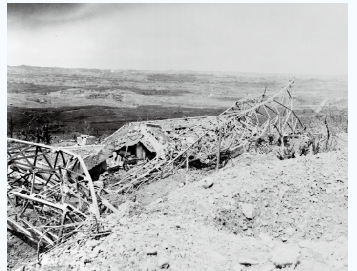
④ 破壊された「首里無線塔 (米軍説明)」 (1945年4月28日) (写真番号:87-27-2)
