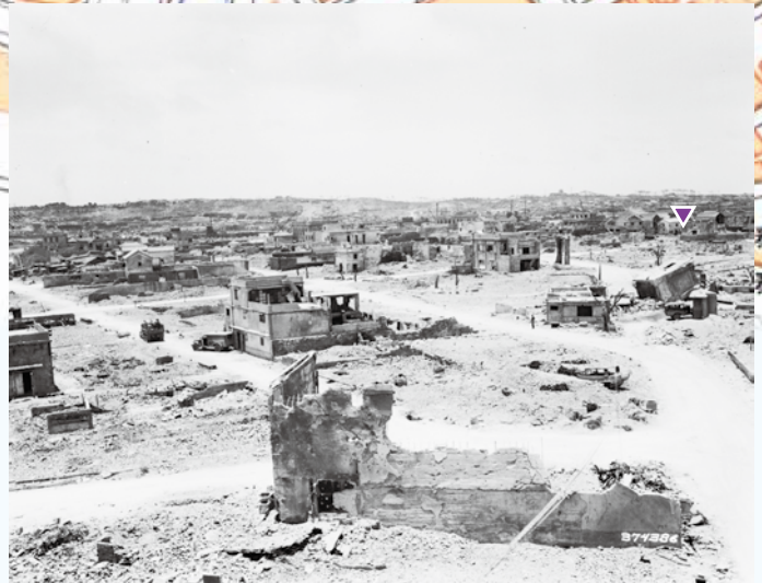
写真⑦ 特徴的な交差点のかたちから、百貨店円山号から南西方向を撮影していると思われます。▼は那覇市役所の建物と思われる、倒壊した塔と考えられます。(1945年6～7月) (写真番号：06-66-4)
