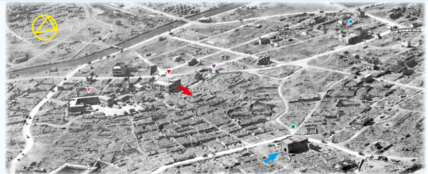
写真③ 前頁の写真を北西側からみた写真です。赤矢印が表紙の写真的撮影方向になります。左側より▼は天妃小学校、▼電話庁舎、▼那覇市役所、◆新天地劇場、◆勸銀支店・百四十七支店になります。新天地劇場の青矢印は、写真⑥と同じで、壁にあいた穴のようです。(1945年7月1日)(資料コード：0000256318)
